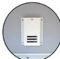
Orifice de ventilation avec thermofusible
